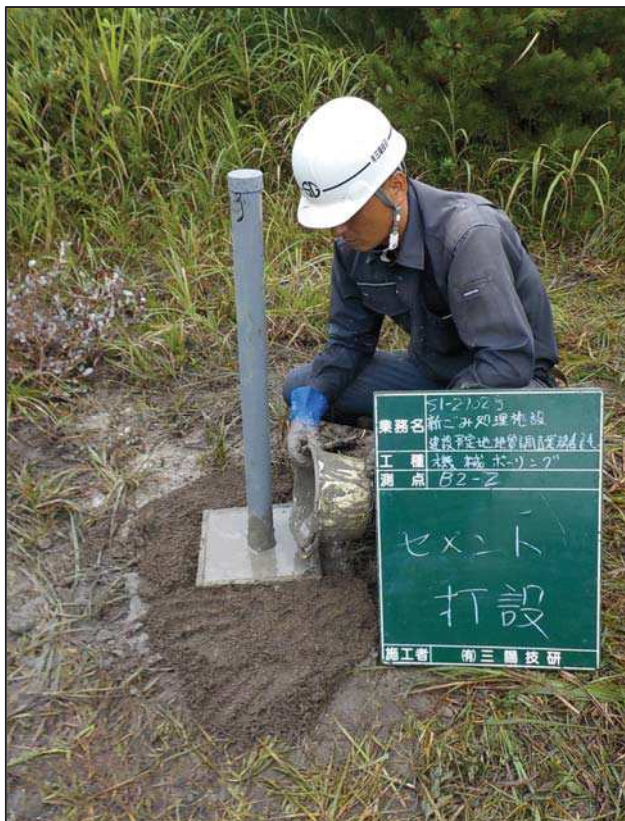
セメント打設
